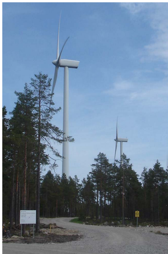
Vindkraftverk i Håcksta vindpark i Hudiksvall med vertikala rotorblad (vingar) samt torn av betong.
